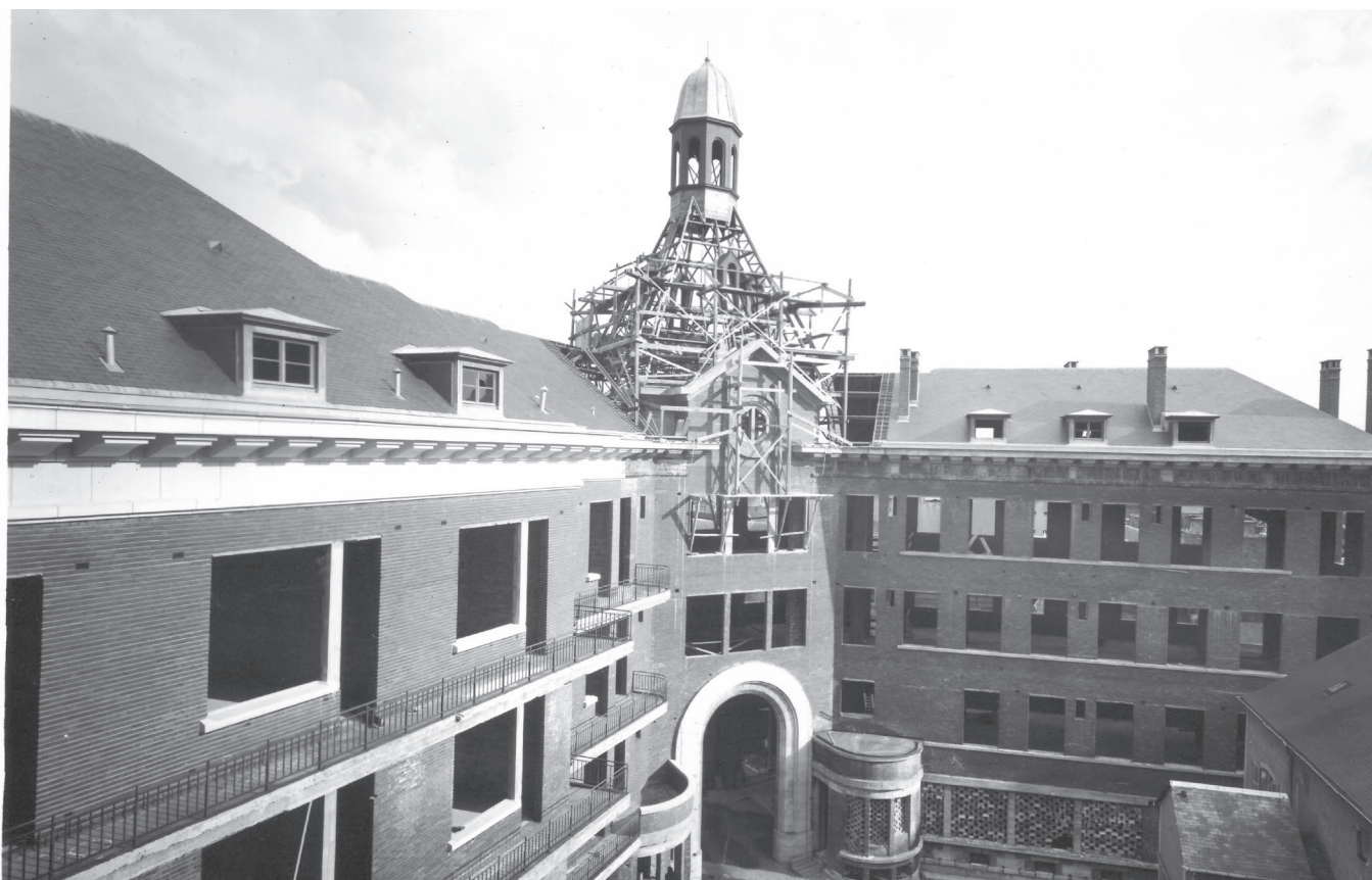
Les nouveaux bâtiments de l'Hôtel-Dieu en pleine construction.
